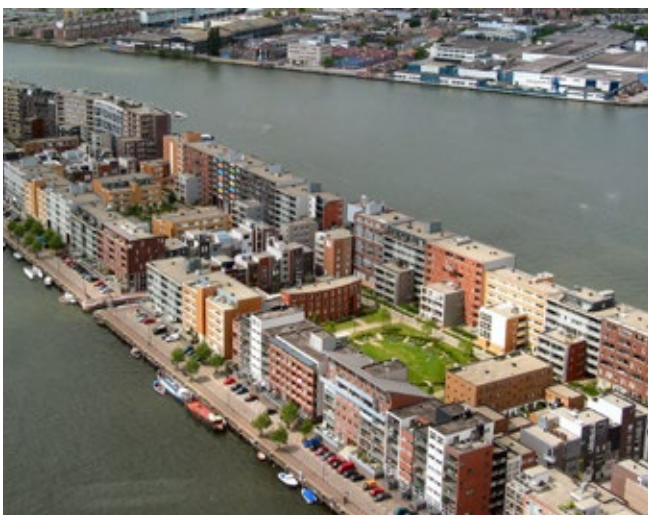
Figuur 4.2.1: Luchtfoto van de wooncomplexen op het Java-eiland in Amsterdam.
